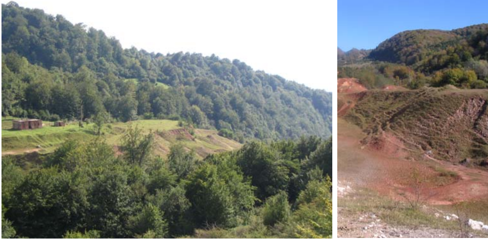
Foto 1. Imagine de ansamblu asupra haldei de steril Comarnic-Poieni cu taluzurile celor 2 trepte și vegetația spontană instalată; detaliu al haldei interioare, văzut din partea sud-vestică a carierei
