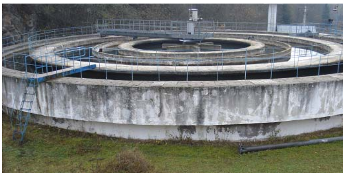
Fig.1.2. Decantorul radial de la stația de tratare a apelor Taia
