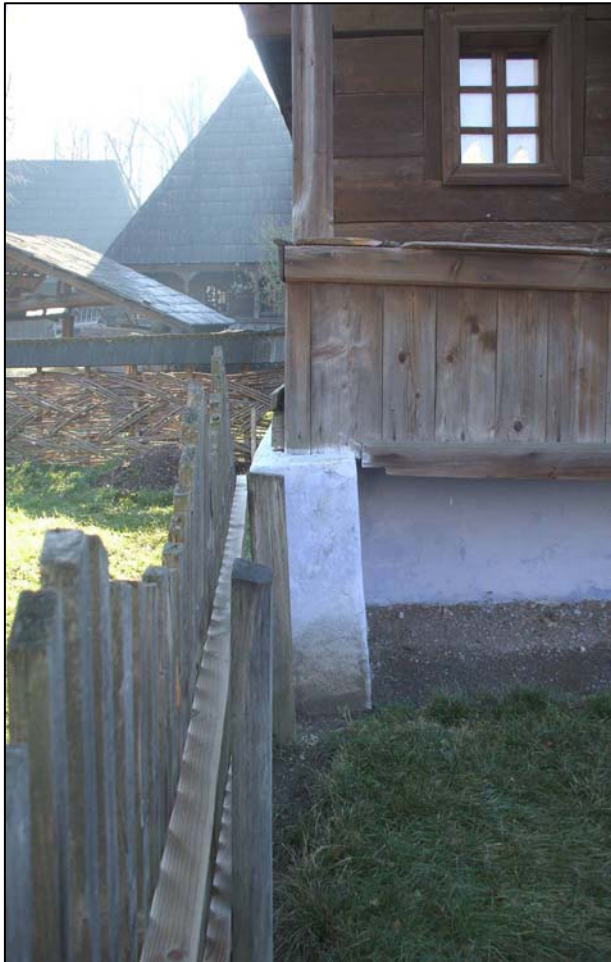
Zidul din coltul nordic al gospodariei, pe fatada laterala, se inclina spre exterior datorita sufoziunii terenului poros in care este fundat
